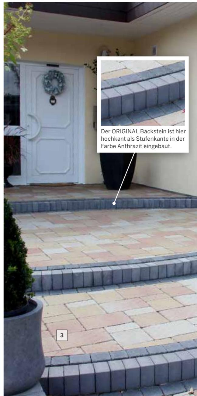
Der ORIGINAL Backstein ist hier hochkant als Stufenkante in der Farbe Anthrazit eingebaut.
