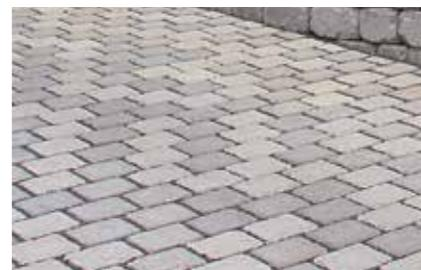
Wasserdurchlässigkeit garantiert – der ORIGINAL mit höherem Fugenanteil.
