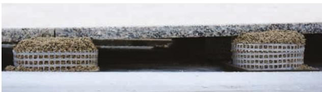
Spezielle Höhenausgleichsringe dienen als Schalung für den Mörtel. Die 27 oder 50 mm hohen Ausgleichsringe können problemlos mehrfach übereinander gesetzt werden. Damit ist der Höhenausgleich von bis zu 150 mm möglich. So lässt sich das Belagsgefälle einfach einstellen (siehe [www.gutjahr.com/technikipp](http://www.gutjahr.com/technikipp)).
