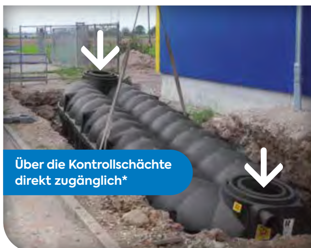
Einbaubeispiel: Versickerungsrigole NEO 15.000 Liter
