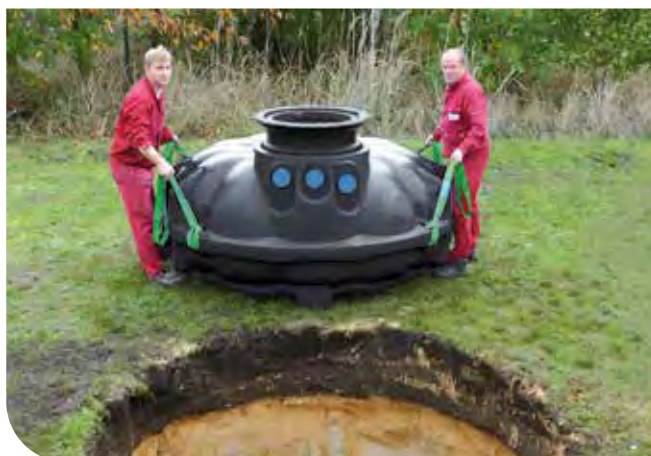
Einbaubeispiel: Flachtank NEO 3.000 Liter
