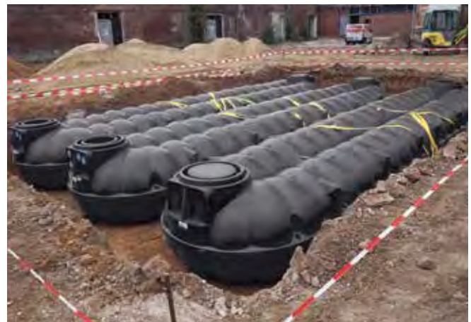
Einbaubeispiel: Großanlage Flachtank NEO 3 x 20.000 Liter
