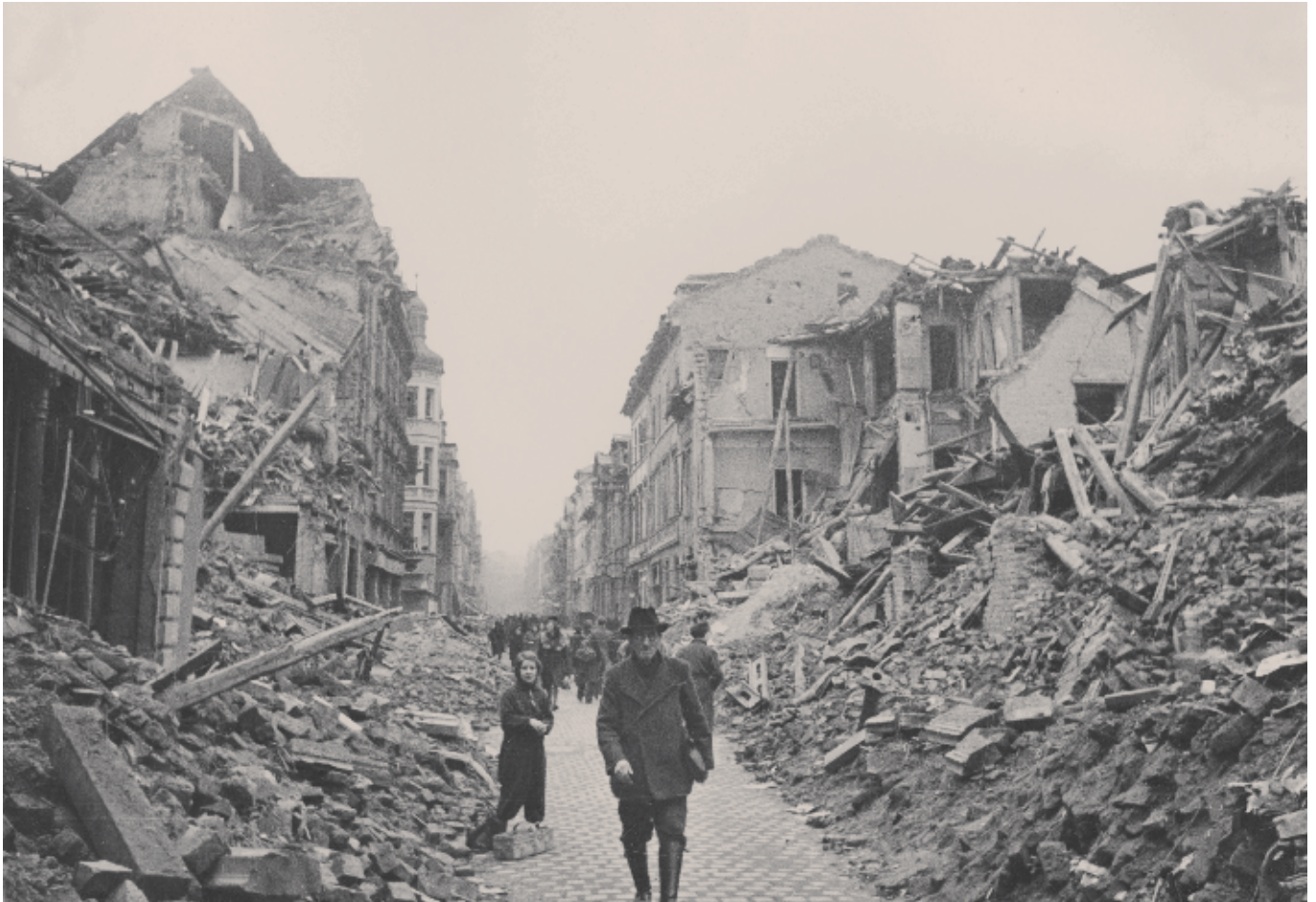
Blick in die teilweise zerstörte Wellritzstraße von der Schwalbacher Straße aus. Vermutlich Februar 1945. Quelle: Stadtarchiv Wiesbaden.
